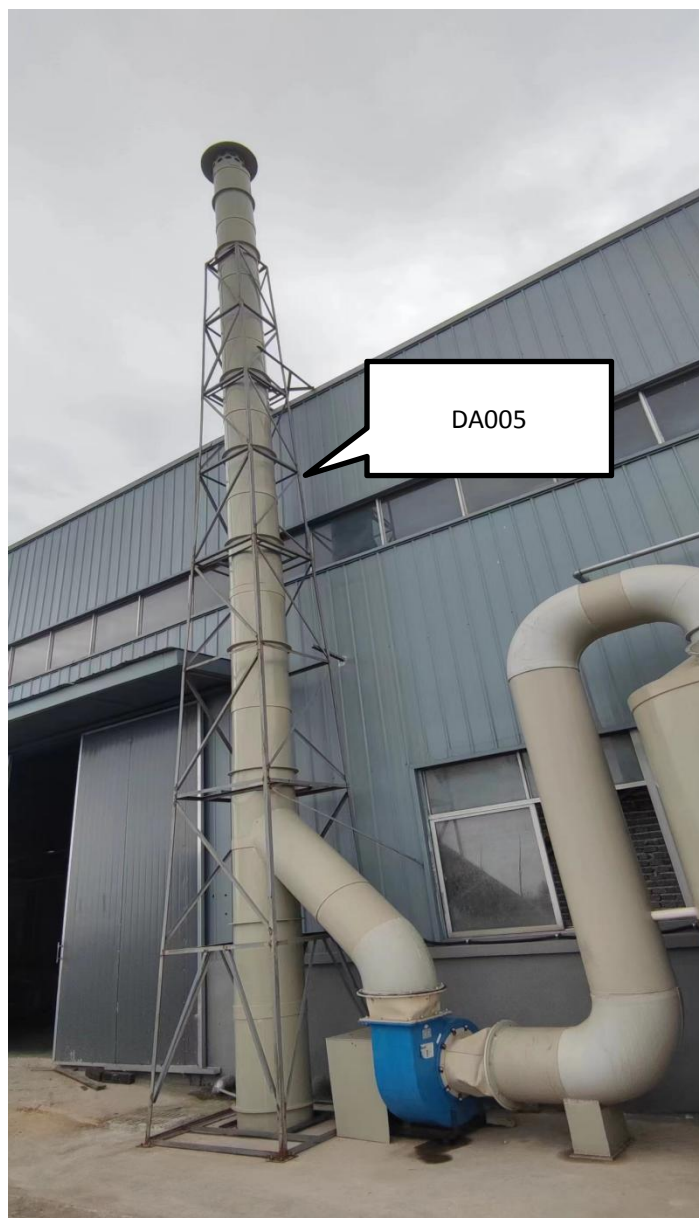
图 3-9 废气治理措施及排气筒图
