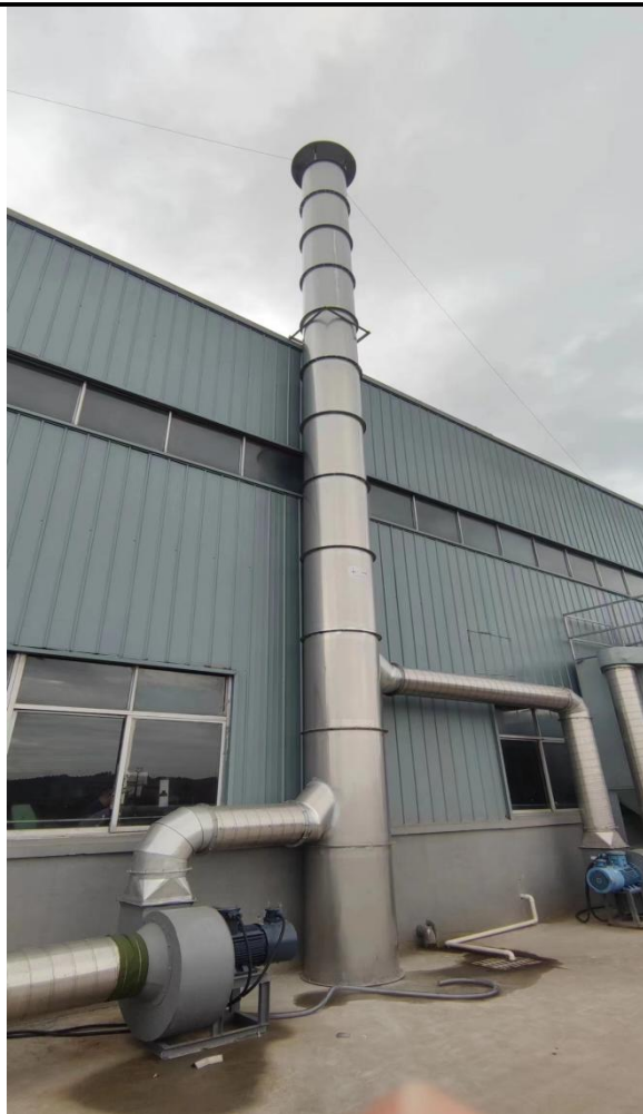
图 3-8 废气治理措施及排气筒图
