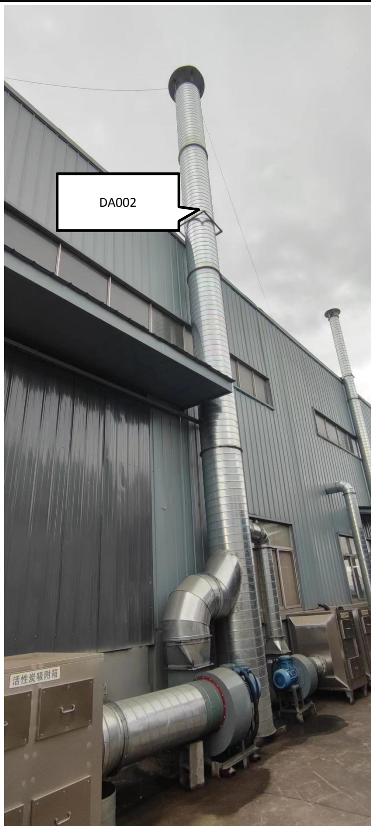
图 3-6 废气治理措施及排气筒图
